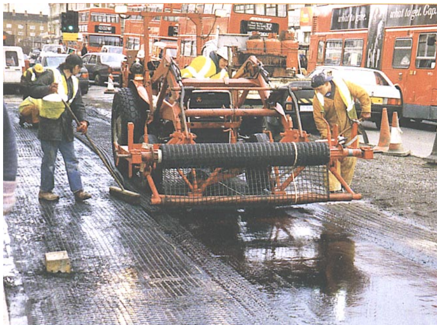
Obr. 6: Pokládka výztužné mřížoviny HaTelit v Londýně
