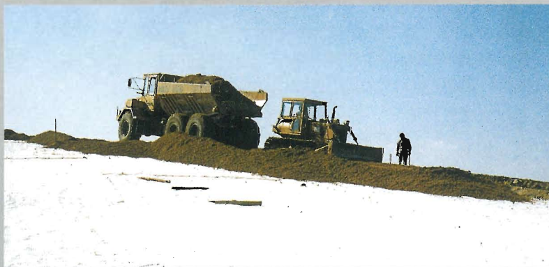
Uzavírání skládky matrací NaBento® - překryvání pískem
