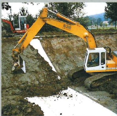
Těsnění říčního koryta matrací NaBento®
