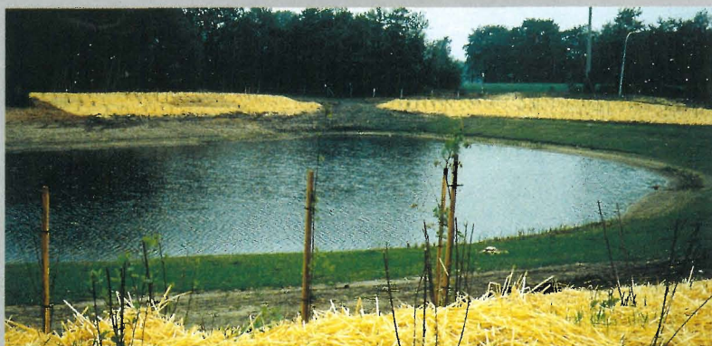
Retenční a usazovací nádrž těsněná matrací NaBento®
