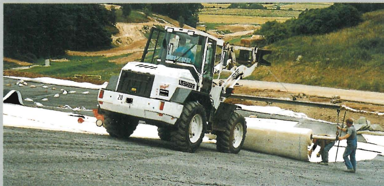
Uzavírání skládky matrací NaBento® - instalace
