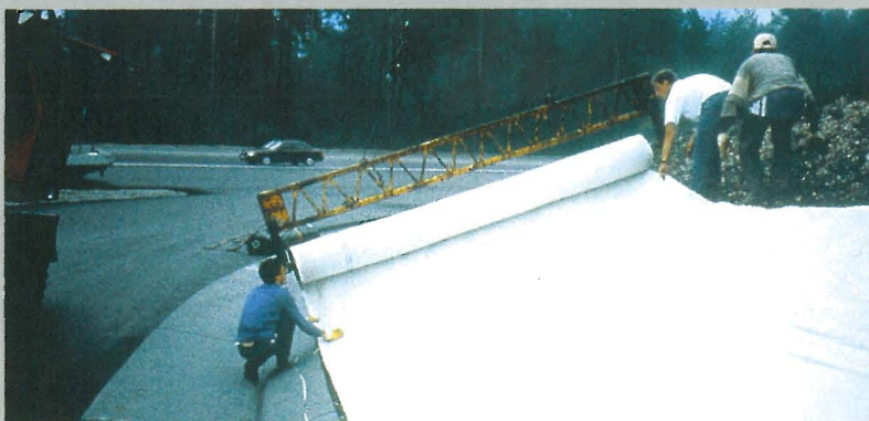
Ochrana podzemní vody u silnice
