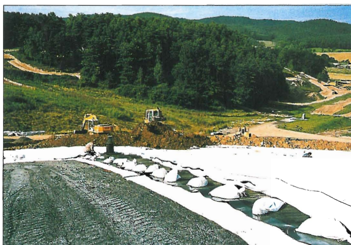
Instalace matrace NaBento® při konstrukci skládky
