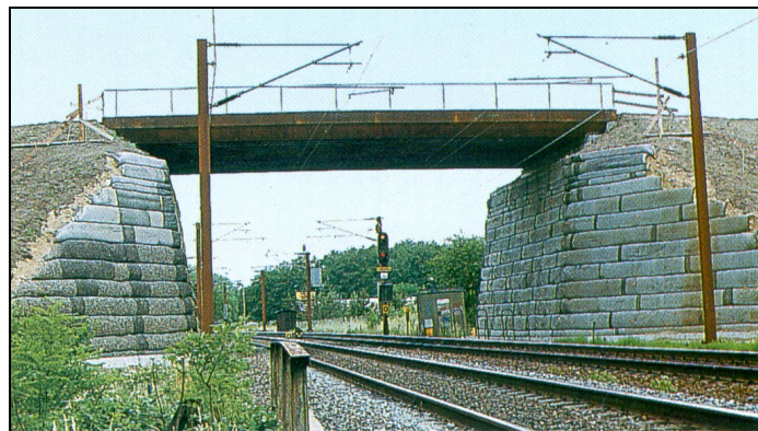
Silniční most s opěrami z vyztužené zeminy v Dánsku
